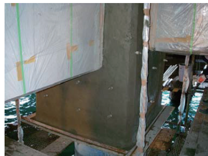
施工完了状況
